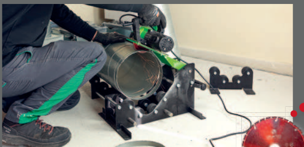
Zeitsparendes Trennen von Lüftungsrohren
