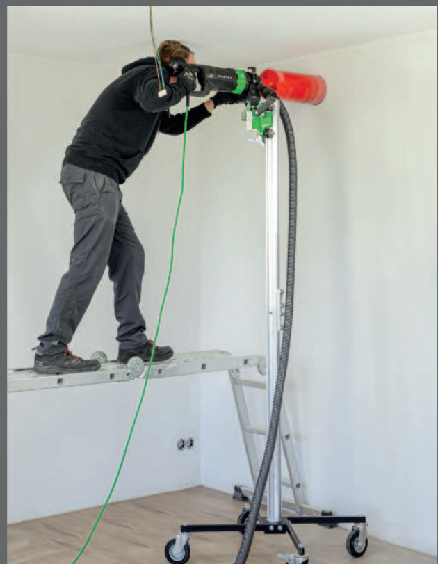
Lüftungsbohrungen bis zu 2,30 m Höhe mit Säulenverlängerung
